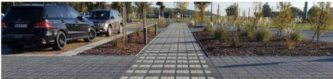
Figure 11 - Photo d'un parking en pavés Ecovégétal
