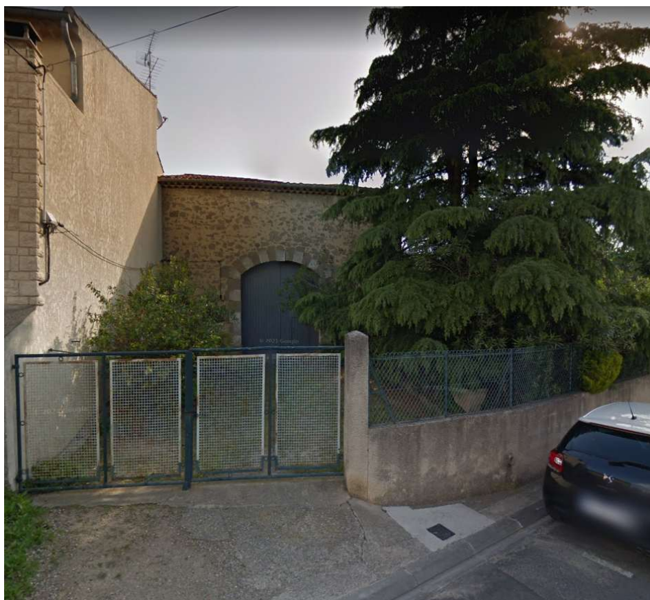
Vue de la parcelle AD0050 (à droite de la grange située sur la parcelle AD 0051) depuis la rue Jean-Jacques Rousseau – Source Gmap.
