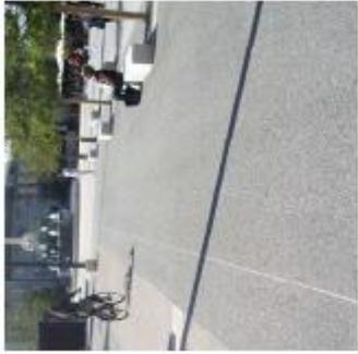
Le traitement grenaille fait ressortir la couleur des gravas constituant l'enrobé. En choisissant des granulats de nature silico-calcaire, le rendu final du revêtement s'éclaircit et vient contraster avec la couleur des chaussées adjacentes. L'enrobé grenaille donne ainsi un aspect résidentiel et piéton à l'aménagement du site.
