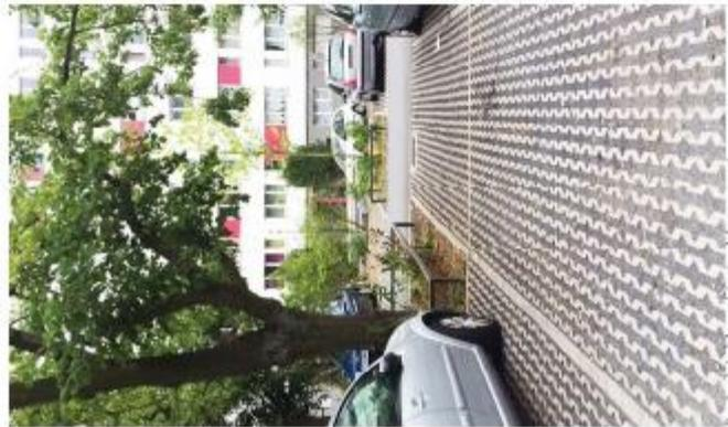
Exemple de revêtement perméable avec creux
