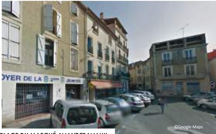
6 PLACE DU MARCHÉ AVANT TRAVAUX
