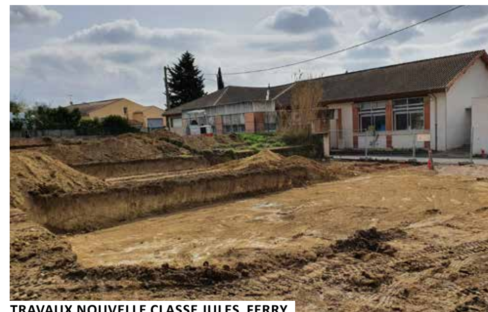
TRAVAUX NOUVELLE CLASSE JULES FERRY
