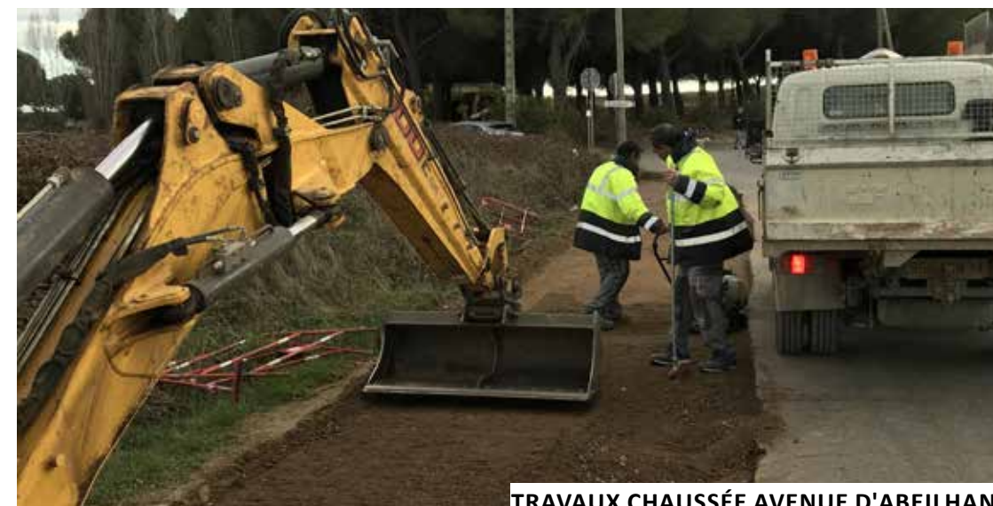
TRAVAUX CHAUSSÉE AVENUE D'ABELHAN
