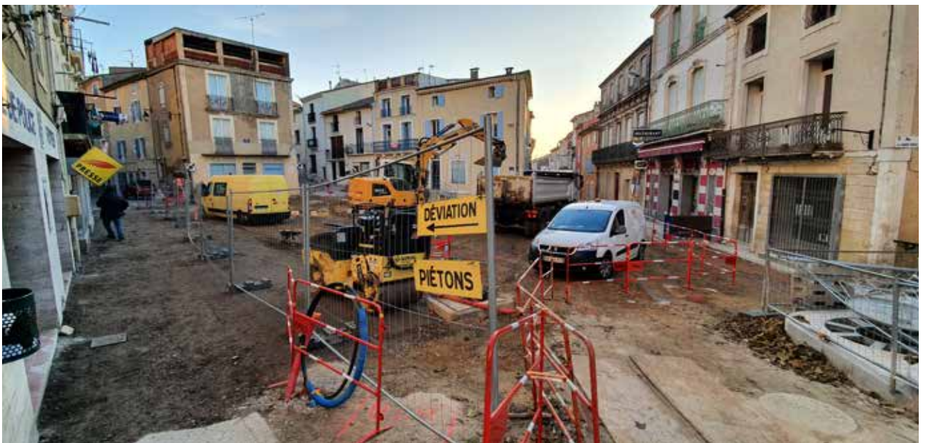
Chantier place du marché
