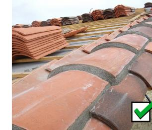
Les rives constituent l'extrémité du toit côté pignon. Elles seront réalisées par une double rangée de tuiles de couvert chaînées et scellées au **mortier de chaux**.
