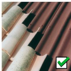
Les plaques sous-toiture rigides en fibrociment (PST) sont à proscrire. Elles sont **inesthétiques, inaptées aux formes souples et irrégulières des toitures anciennes (risque de casse ou fêlures selon les mouvements de la charpente)**.
