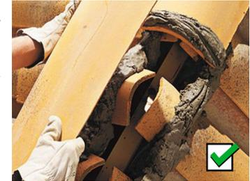
Les faîtages avec des closoirs ventilés ne sont pas appropriés aux toits anciens. Ce montage à sec ne permet pas de maintenir les dispositions d'origine correspondant à l'époque de construction de l'immeuble.
