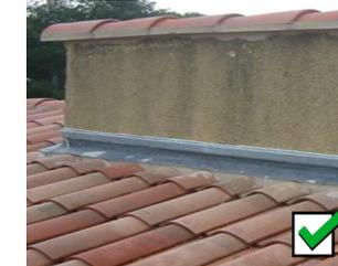
Les solins seront exécutés en **plomb** pour une bonne adaptation aux tuiles canal avec une bande porte solin recouverte par l'arrêt de l'enduit.
